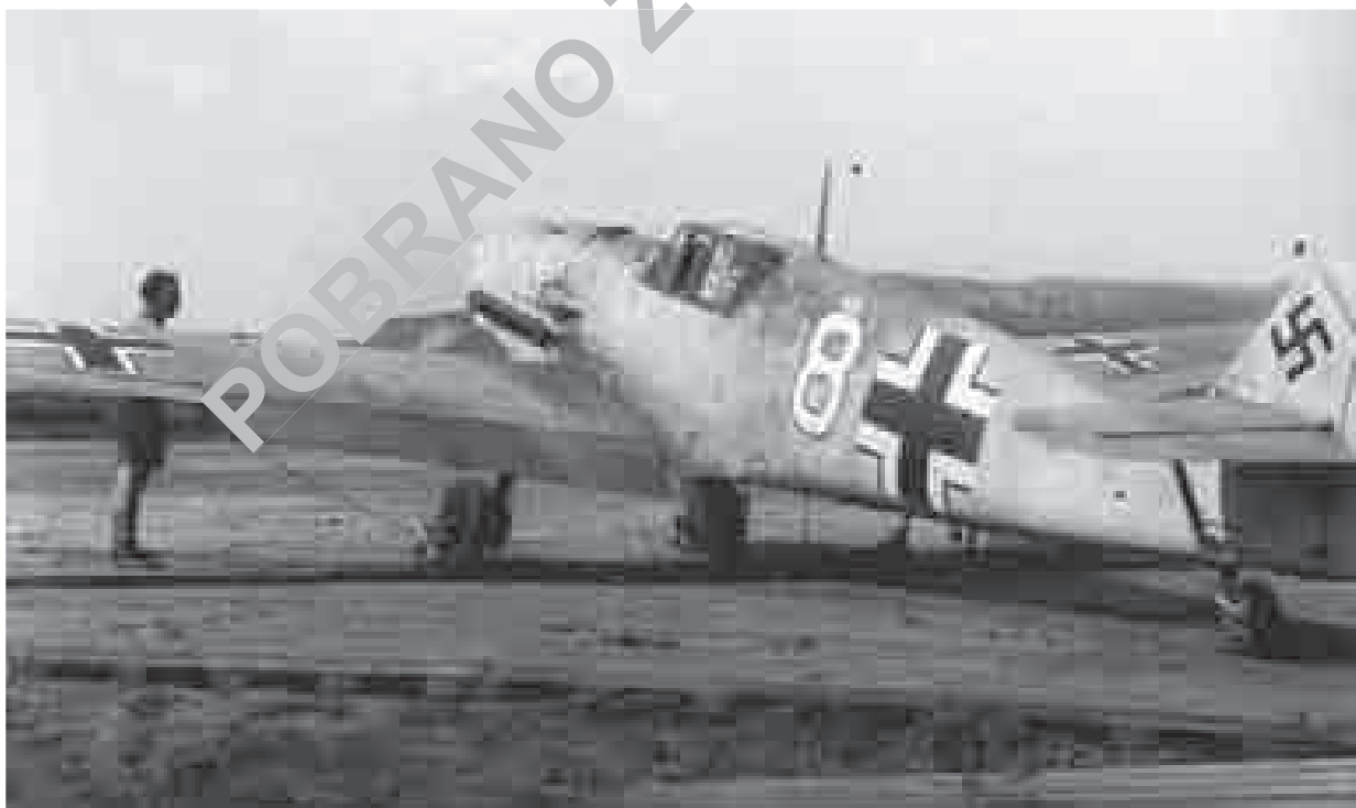
Ten sam samolot podczas próby silnika przed startem. Pod kadłubem antena FuG 25. The same aircraft having its engine warmed up prior to take-off. Note Fug 25 antenna under fuselage. (via Barbas)
